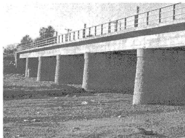
写真-3 橋梁全景写真 (橋梁 No.3)
