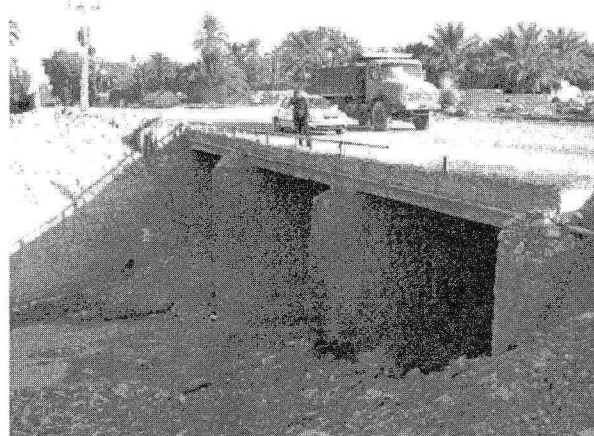
写真-2 橋梁全景写真 (橋梁 No.2)
