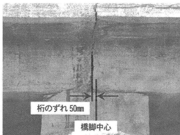
写真-6 その他の橋脚上の掛違い部
