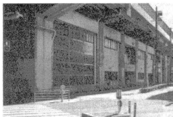
写真-1 現地状況
