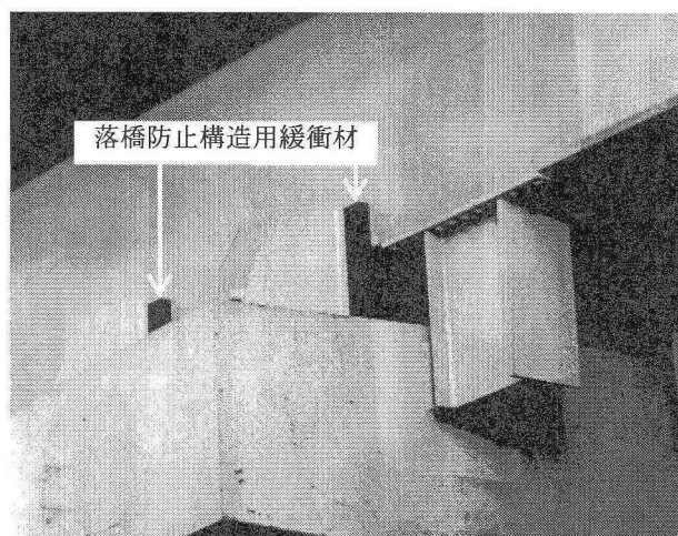
写真-3 落橋防止構造用緩衝材の設置例
