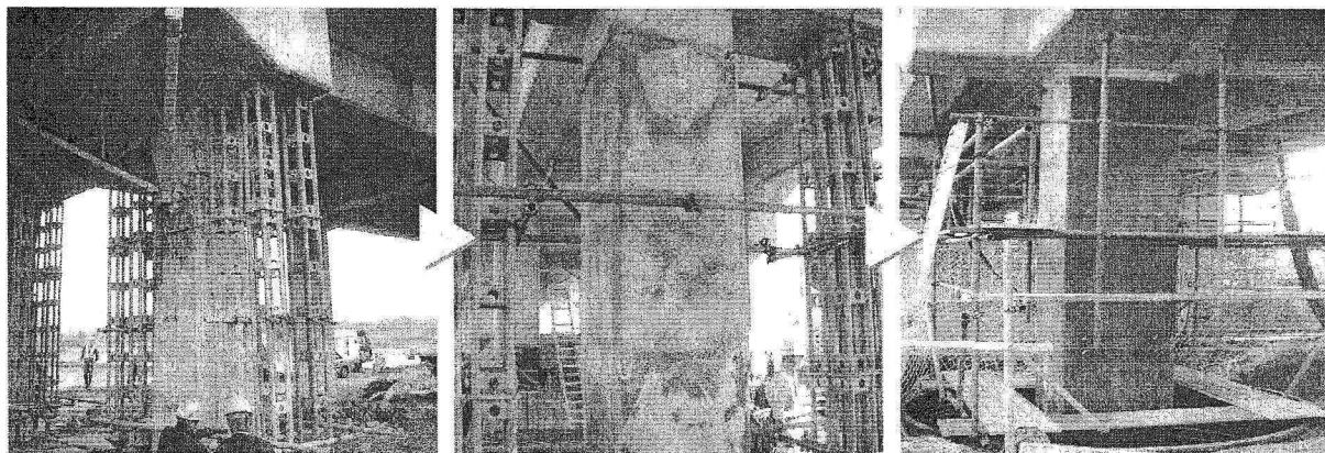
写真-11 応急・復旧作業の概要
