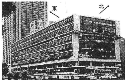
図-1 被害写真(北東角) 2)
