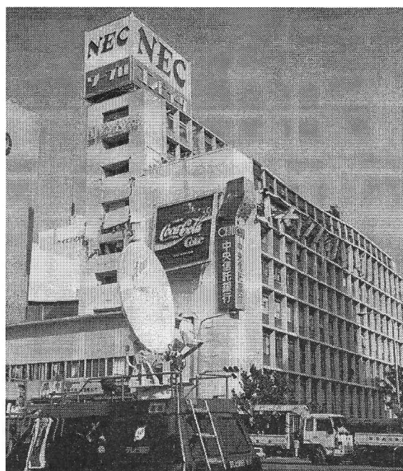
図-26 被害写真（南角） 7)
