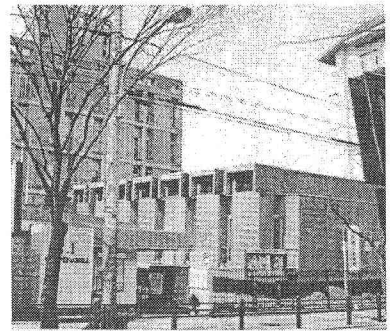
図-12 被害写真（南東面） 3)
