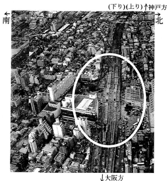
図5 六甲道駅高架橋 12)
