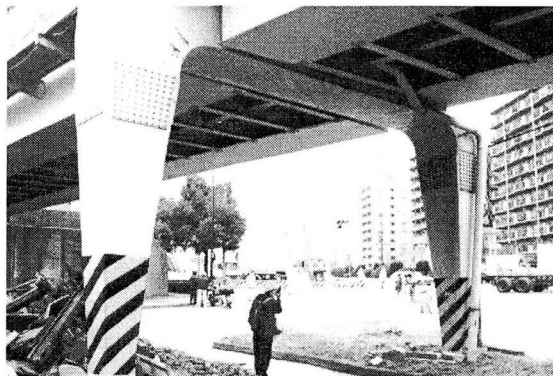
写真-2 門型ラーメン橋脚 (P2)
