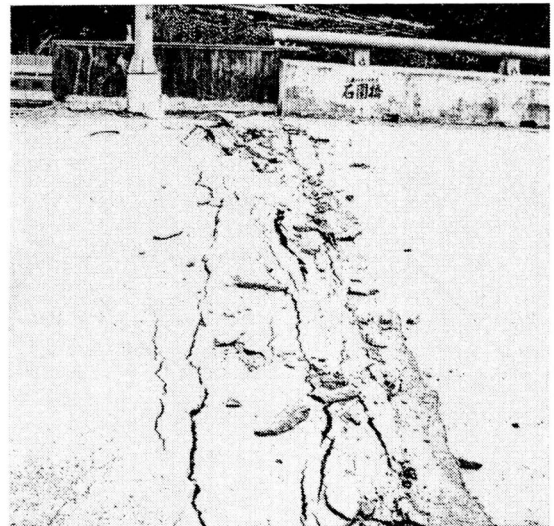
写真-6 卓欄方面線 A1 橋台付近の損傷
