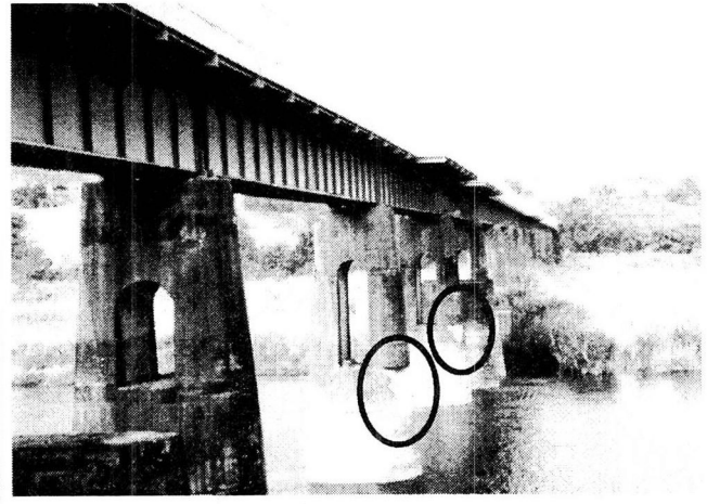
写真－9 旧鉄道橋（現在、歩道橋）の損傷
