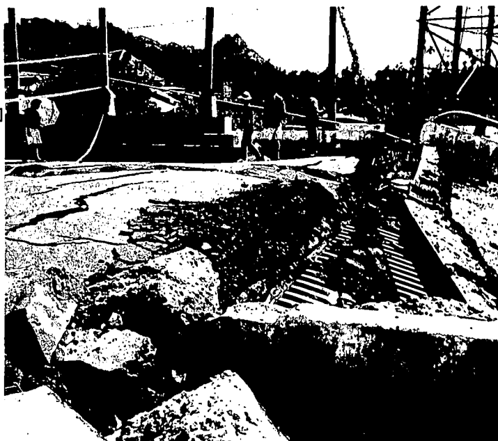
図-4 橋台部損傷状況写真
