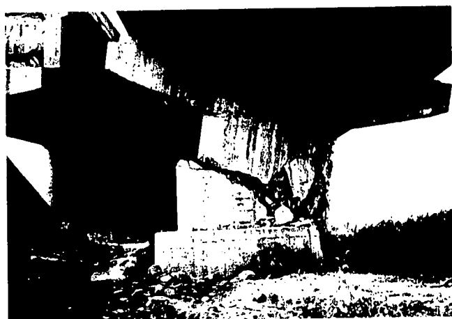
写真－５ 新橋のP 2 橋脚の被害
