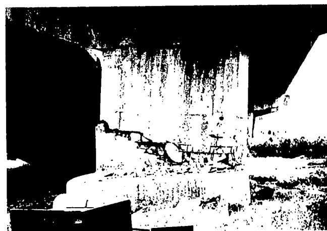
写真－４ 新橋のP 1 橋脚の被害
