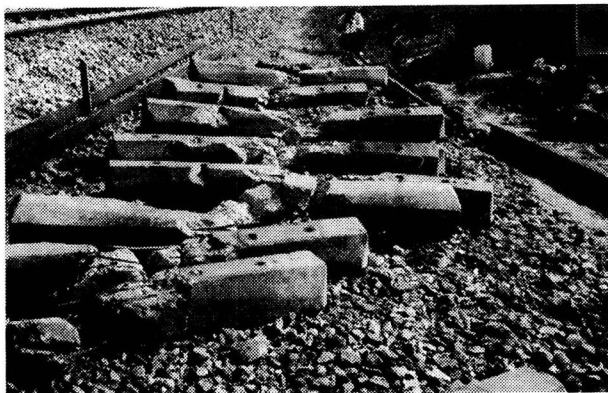
写真－21 撤去されたレールと枕木
