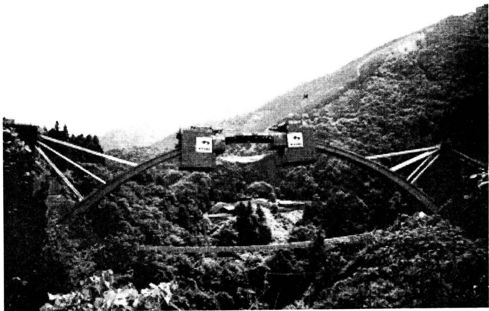
写真-1 工事状況
