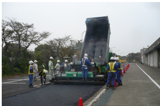
写真-4 高機能混合物の敷均し状況
