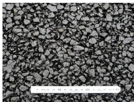
写真-5 再生高機能混合物の仕上がり路面
