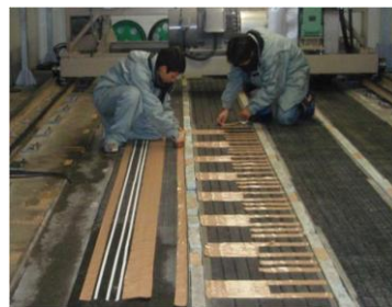
写真-4 氷板路面作製作業の状況
