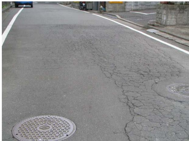
写真-3 ひび割れ破損レベル3の例
