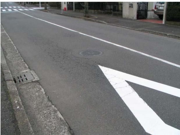
写真-2 ひび割れ破損レベル2の例
