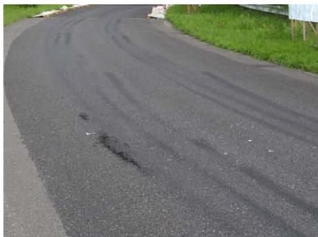
写真-1 側方流動破壊発生状況
