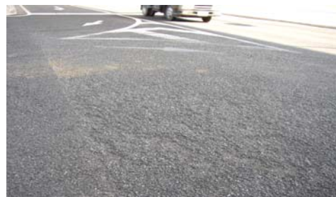
写真-1 骨材飛散状況
