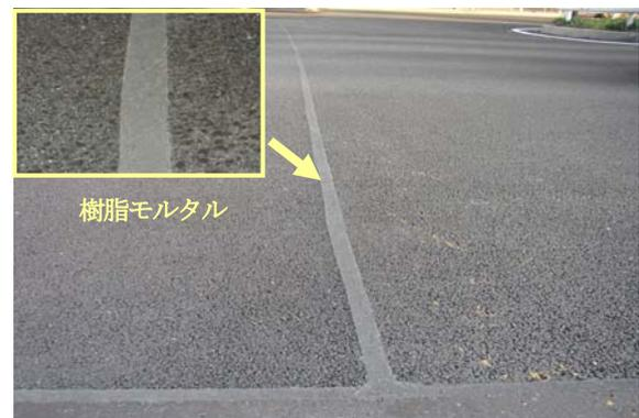
写真-2 ジョイント部の補強例
