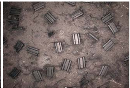
写真-3 ゴムロールド舗装(「改良型」)
