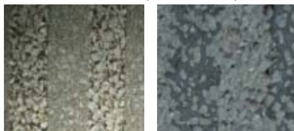
開粒度充填舗装（充填割合 50%）
