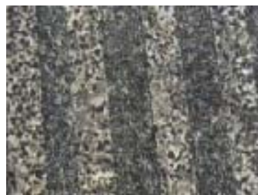
開粒度充填舗装（充填割合 50%）
