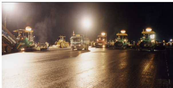
図-7 新千歳空港ホットジョイント施工状況例
