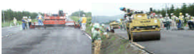
写真-4 セミホット混合物施工状況
