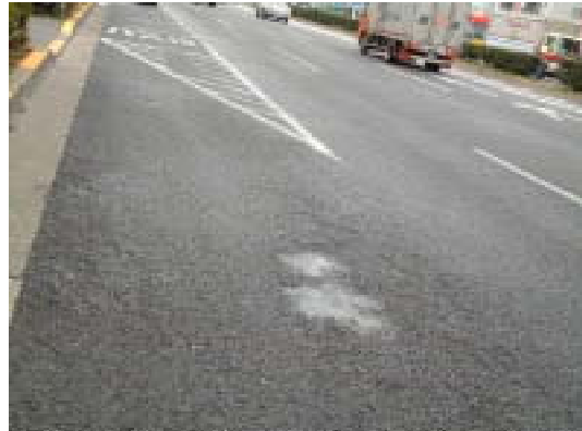
写真-5 部分補修した箇所
