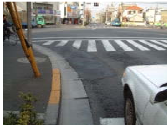
写真-4 ホットホールの発展しそうな骨材飛散箇所
