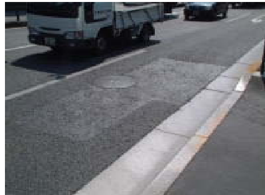
写真-6 骨材飛散を樹脂コート工法で補修した箇所
