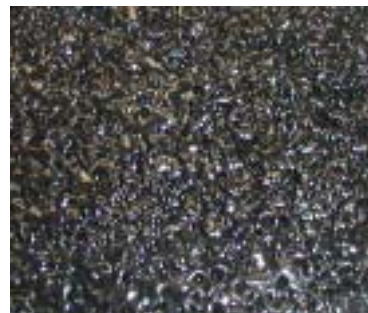
写真-7 排水性舗装
