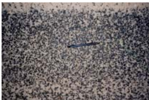
写真-2 肌理の凸部の雪氷が消耗した排水性舗装
