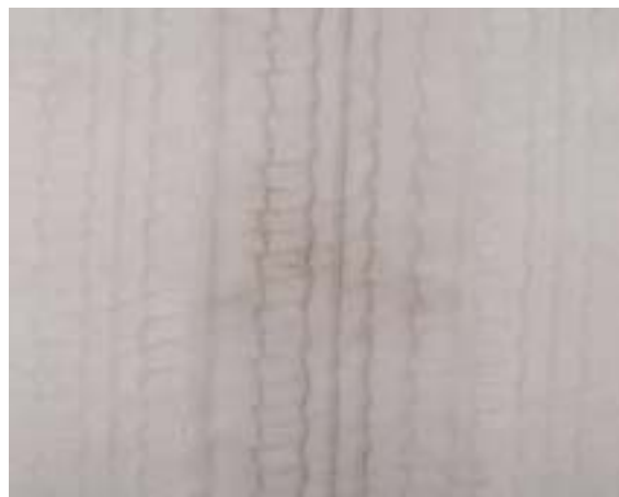
写真-10 通過輪数 1000 回での圧雪路面(鱗片状に氷膜と薄い氷板が生成されている)
