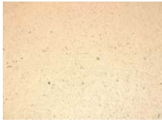
写真-5 高強度舗装の舗装表面 (区間)
