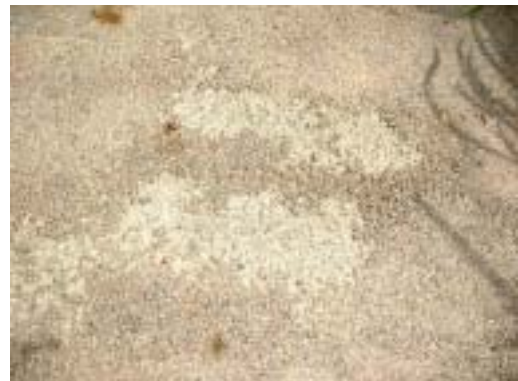
写真-6 透水舗装の舗装表面 (区間)
