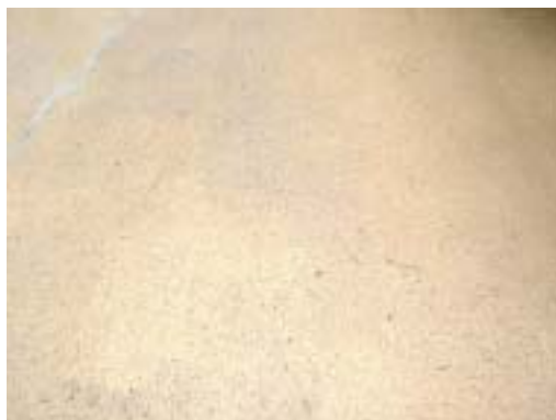
写真-4 トップコートの舗装表面 (区間)
