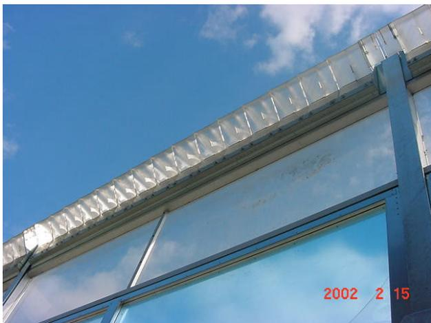
写真-1 透光性とした反共鳴管付遮音壁の設置状況
