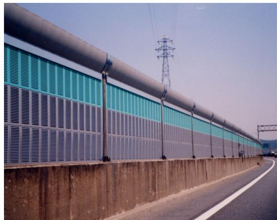
写真-2 遮音壁設置状況
