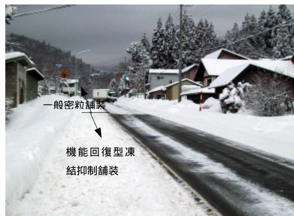
写真 4 岩手県雫石町の車道一般部で確認された効果
