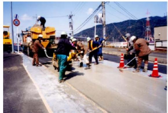
写真 1 機能回復型凍結抑制舗装の施工状況
