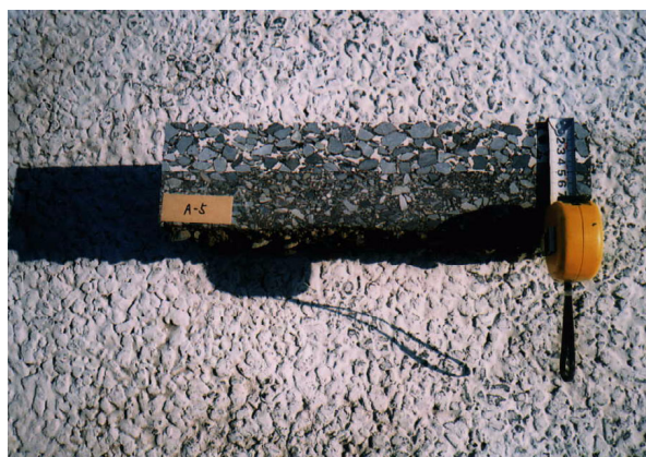
写真-2 切り出した舗装体の断面 （保水性舗装 5cm）
