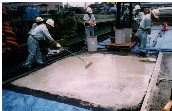
写真-1 保水性セメントミルクの充填状況
