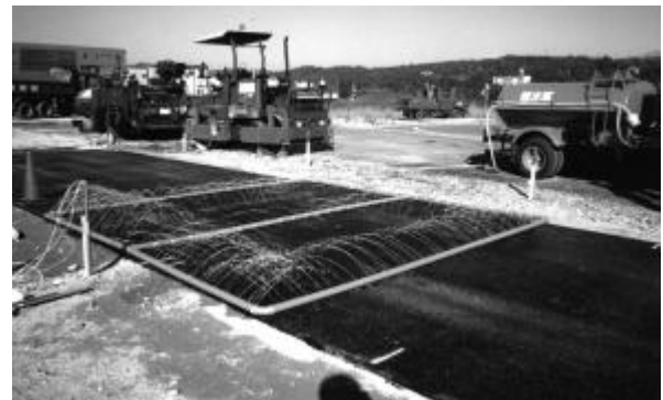
写真-1 舗装体への散水状況
