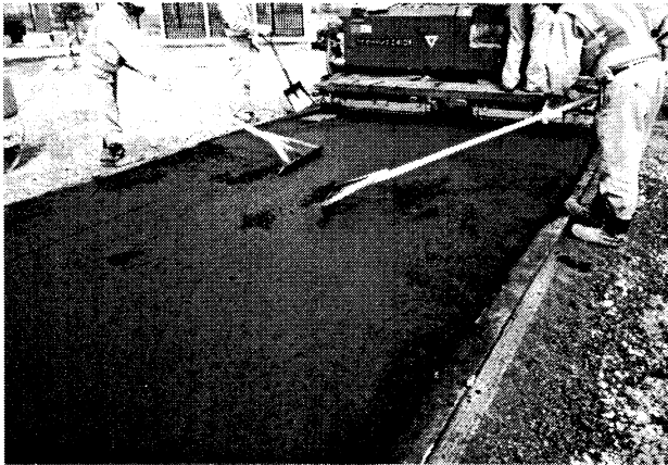
写真-1 中温化細粒Gの敷均し状況 (StAs 80/100, 出荷温度 110℃)
