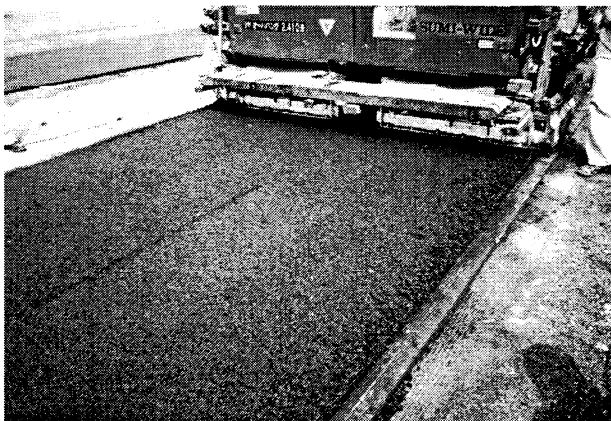
写真-2 中温化高機能SMAの敷均し状況 (改質Ⅱ型, 出荷温度 130℃)
