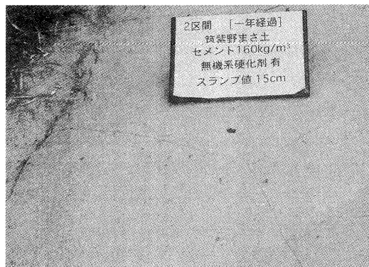
写真-3 2区間の舗装体状況
