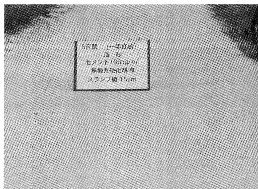
写真-4 5区間の舗装体状況
