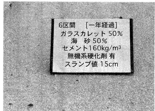
写真-7 6区間の舗装体状況
