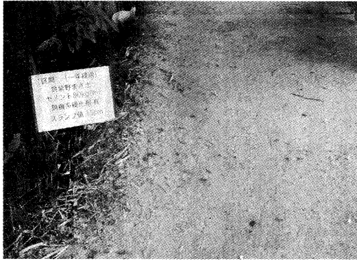
写真-5 1区間の舗装体状況
