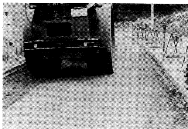
写真－３ 石炭灰路盤材の転圧状況
