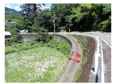
図-6 既設進入路
