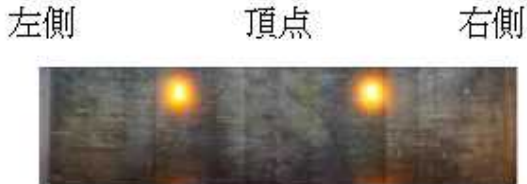
図-4 1スパンの覆工画像展開図(13枚使用)
