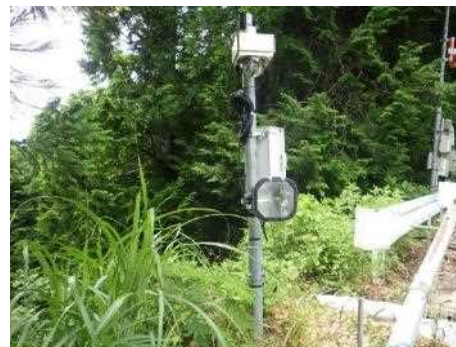
写真-3 カメラ設置状況
