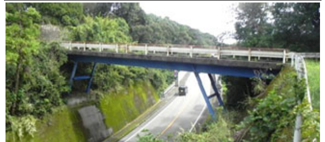
写真-1 橋梁全景
