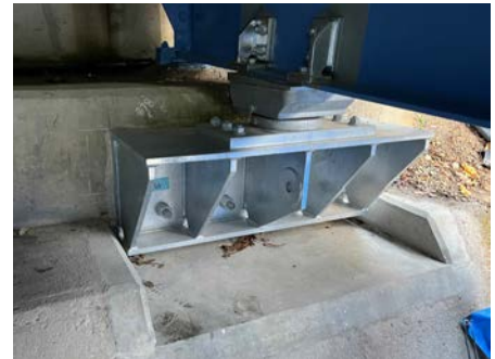
写真-2 水平力分担構造の設置状況
