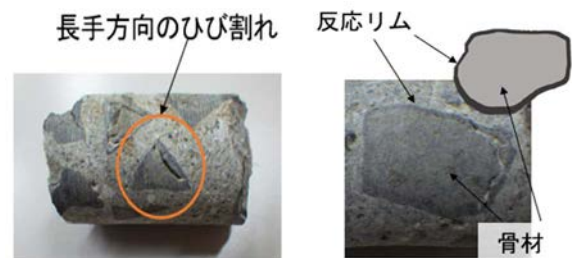
図 8 骨材のひび割れ 図 9 骨材の反応リム
