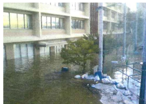
写真 1 浸水被害の様子
