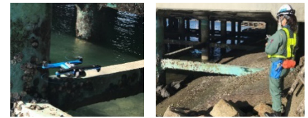
写真-3 衝突回避型ドローン操縦状況
