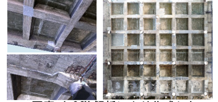
写真-4 SfM解析により作成した 栈橋 3D モデル
