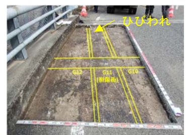
写真-3 舗装撤去による調査
