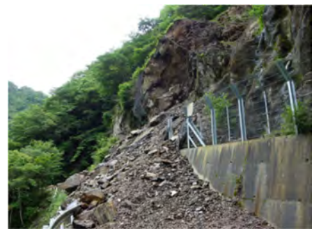
図-2 挙動⑤の岩塊崩落による道路寸断状況
