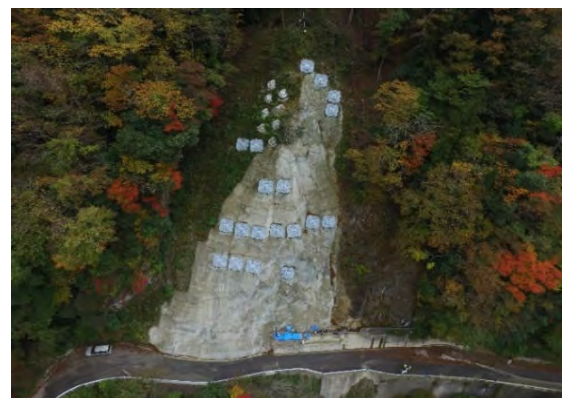
図-7 斜面对策工完了
