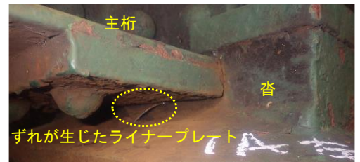
図3 ライナープレートのずれ
