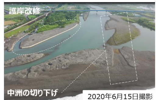
図-2 国土交通省が行った護岸改修と河道中央に流れを寄せるための中洲と河口砂州の掘削
