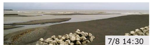
図-4 複数の出水後に低水護岸前方に堆積した土砂
