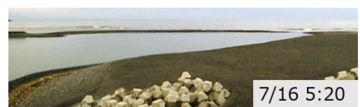
図-5 波浪の影響で右岸の砂州開口部が閉塞する状況
