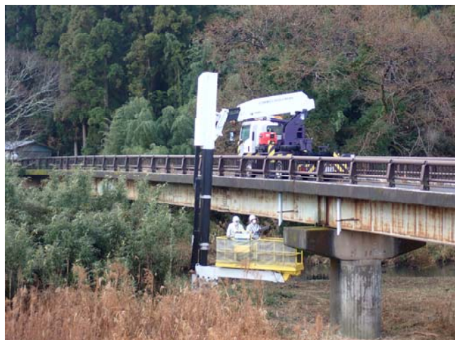
写真-1 橋梁点検車を活用した橋梁点検
