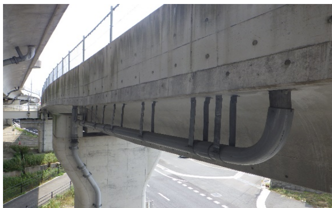
写真-3 観測した導水型排水管
