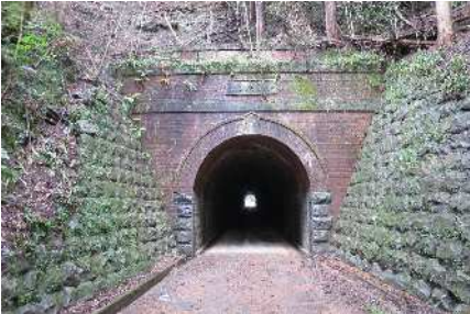
写真 1 熊井隧道の坑門
