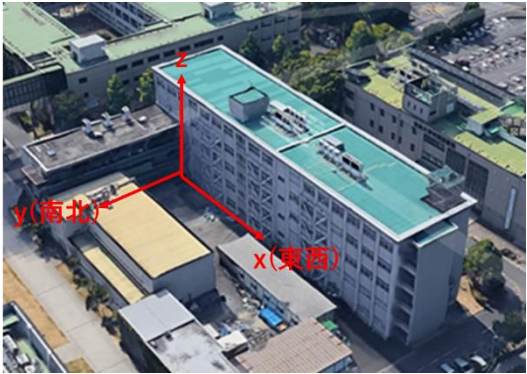
写真 1 対象構造物の外観
