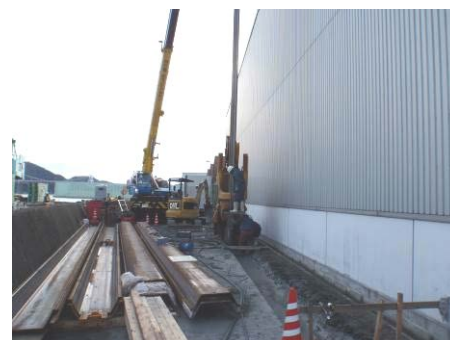
図2 防護矢板の施工状況
