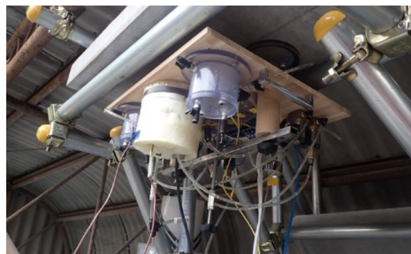
図-1 本手法を180度面に適用した状況
