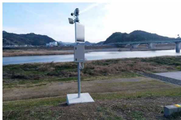
図-3 簡易型河川監視カメラ（仁淀川右岸 10.8k 付近）
